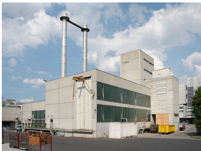
Abbildung 1: Gebäudehülle bestehende Heizzentrale mit Reservekesseln
