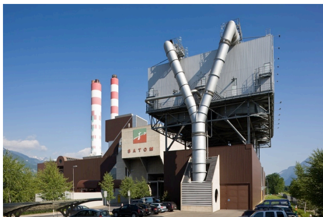
Abbildung 1: SATOM Kehrichtverbrennung, Monthey, Blick auf die Kondensationsanlage
