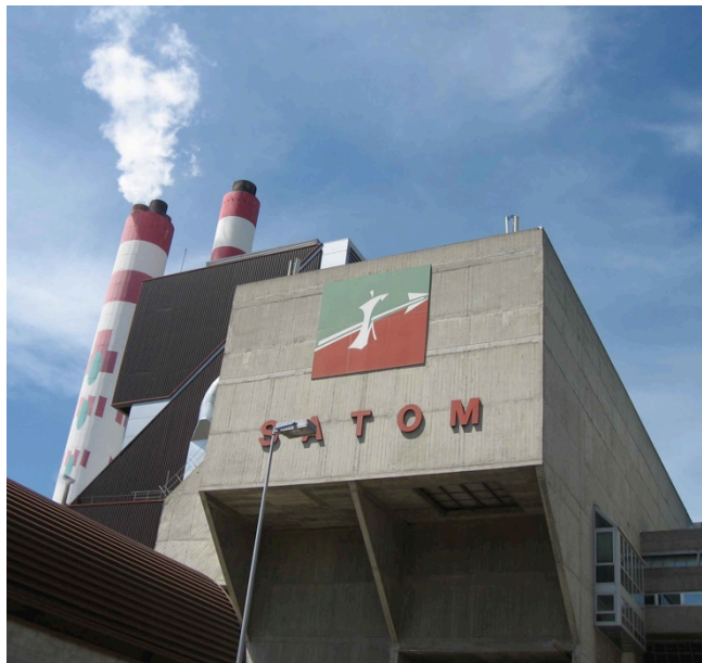
Abbildung 1: Kehrlichtverbrennungsanlage SATOM in Monthey
