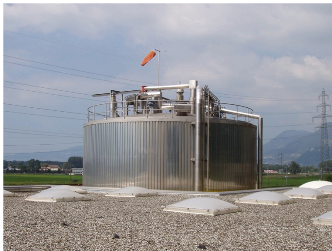
Abbildung 2: Blick vom Dach der Aufbereitungshalle auf den vertikalen Fermenter der Vergärungsanlage
