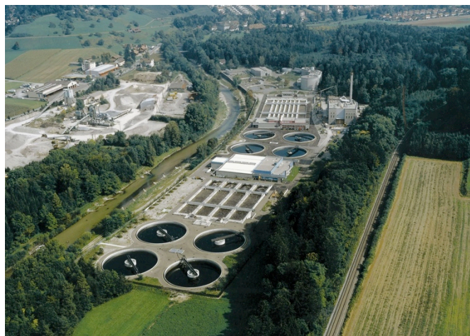
Abbildung 1: ARA von Stadtwerk Winterthur in der Hard und bestehende KS-Verbrennung
